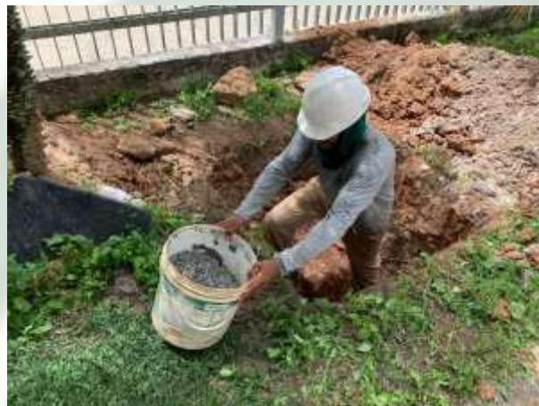
FOTO 08 APLICAÇÃO DE CAMADA DE BRITA.
