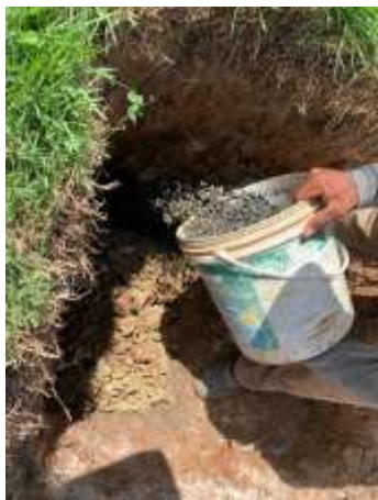
FOTO 07 APLICAÇÃO DE CAMADA DE BRITA.
