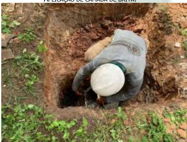
FOTO 09 APLICAÇÃO DE CAMADA DE BRITA.
